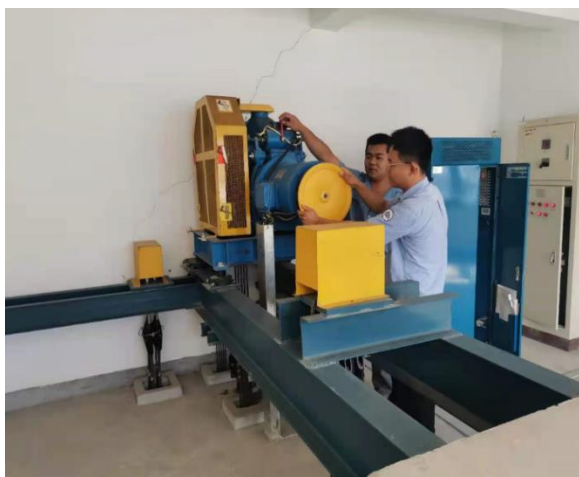
电梯脱困应急演练
